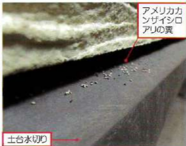
左/床下換気口にメッシュを張ってアメリカカンザイシロアリ対策を施した例 右/土台水切り上の通気層の入口に溜まっていたアメリカカンザイシロアリの糞。ここから通気層内に侵入したと見られる
