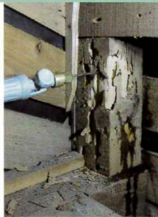
左/アメリカカンザイシロアリの駆除の様子。材のなかに巣をつくるので木部がボロボロになる 右/駆除中に姿を現した個体。建物のなかにこうした巣が複数あることが多い
