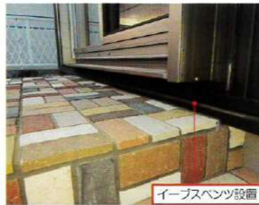
左/通気層の入口(吸気口)にイーブスペンを設置した事例。アメリカカンザイシロアリの侵入を物理的に防ぐ
