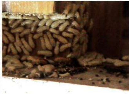
左/アメリカカンザイシロアリの駆除の様子。材のなかに巣をつくるので木部がボロボロになる 右/駆除中に姿を現した個体。建物のなかにこうした巣が複数あることが多い
