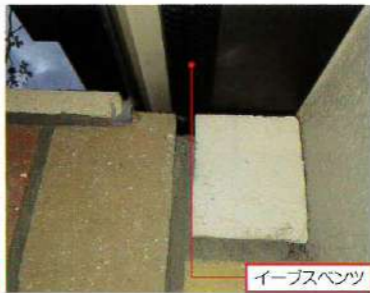
左/通気層の入口(吸気口)にイーブスペンを設置した事例。アメリカカンザイシロアリの侵入を物理的に防ぐ
