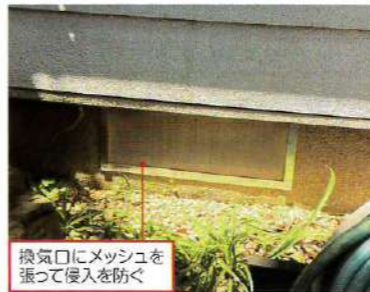
左/床下換気口にメッシュを張ってアメリカカンザイシロアリ対策を施した例 右/土台水切り上の通気層の入口に溜まっていたアメリカカンザイシロアリの糞。ここから通気層内に侵入したと見られる
