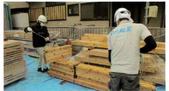
アメリカカンザイシロアリ対策としてすべての構造材と合板にホウ酸を散布。建て方前に散布することで仕口部分にも処理できる
